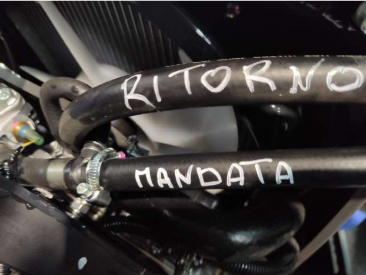
Collegamento tubi riscaldamento con pompa acqua nel vano motore
