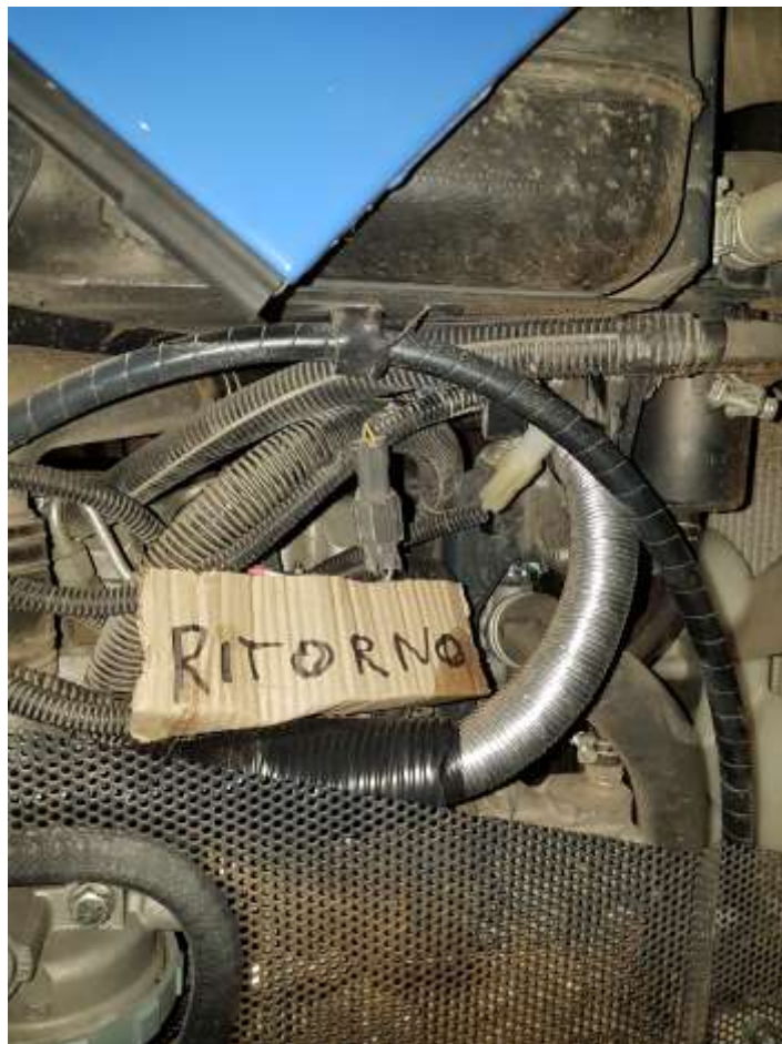
POSA TUBO RITONO RISCALDAMENTO
