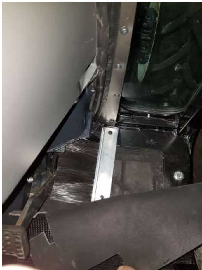
POSA SPAZZOLINI INTERNO CABINA
